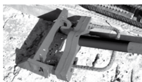
FIG. 13A - PRÉDALLE SUSPENDUE AVANT DÉPLIAGE DES ATTENTES ET DES SUSPENTES
