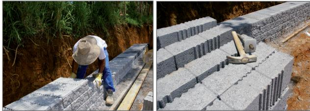
Des murs de soutènement pouvant être réalisés facilement, avec une mise en œuvre simplifiée (blocs manu portables), même dans des sites difficiles d'accès.
