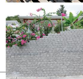
Depuis 7 ans, **Sapeb** fabrique localement et commercialise LEROMUR®, un procédé breveté qui consiste à réaliser des murs modulaires à partir de blocs entièrement constitués de béton.
